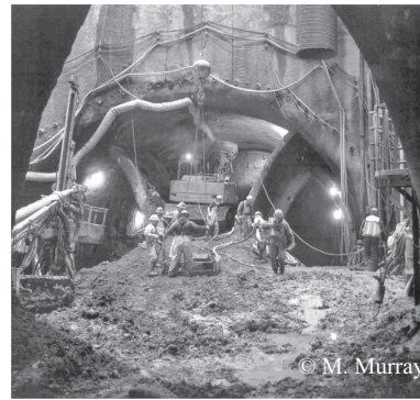
(d) Twin side gallery and central core
